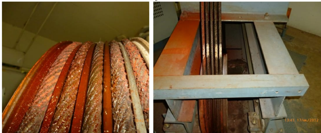
1.3.4 สลิงลิฟต์ต้องไม่เป็นสนิม มีสีหรือสัญลักษณ์แสดงการจอดของลิฟต์ที่สลิงลิฟต์
